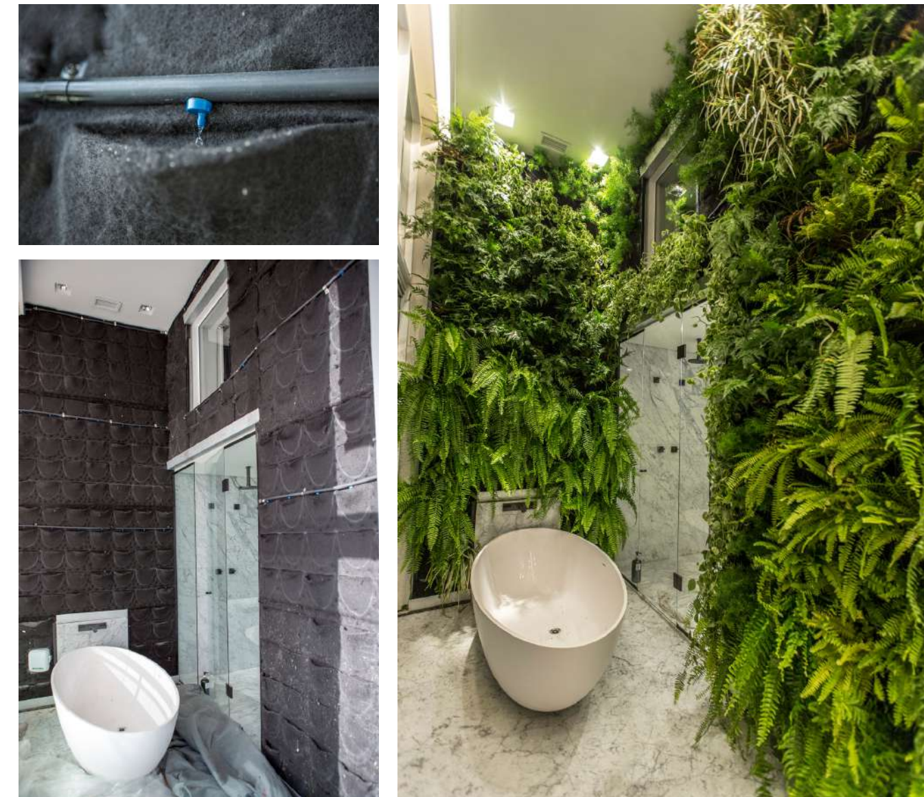
Jardim vertical natural (vivo) com irrigação automatizada
